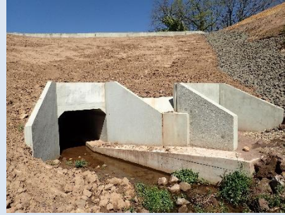
Ouvrage hydraulique (BKM)
