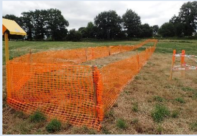
Filet de chantier orange (BKM)
